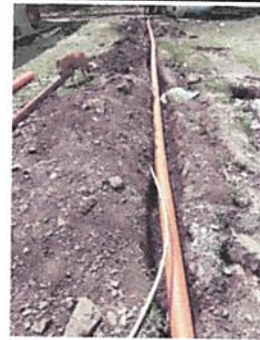
Foto 4: sanjeo e instalación de tubo para drenaje
