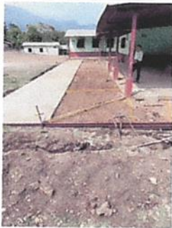
Foto 3: fundición de primera parte del piso de concreto
